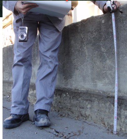
- 煙突の落下と20cmの地盤沈下が見られた
