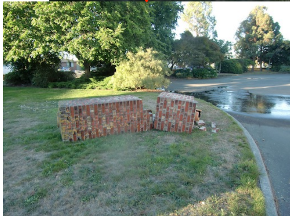
- 煙突の落下と20cmの地盤沈下が見られた
