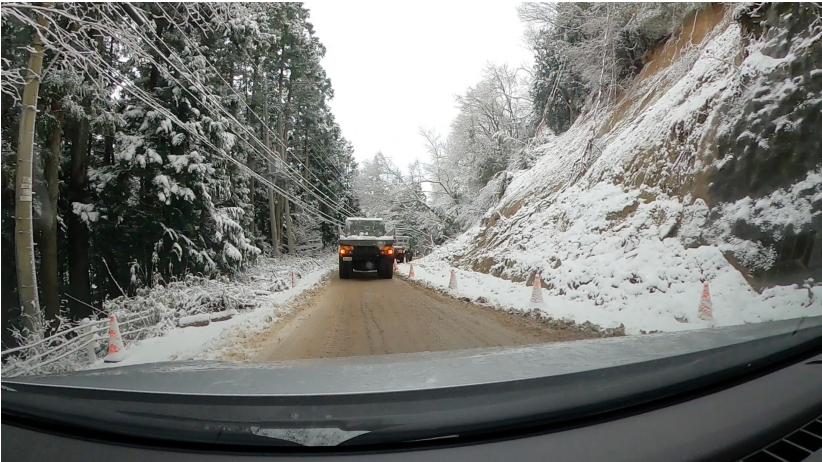
地点A（斜面崩落）
